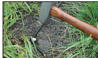
Asegura el tubo en el lado opuesto de la carretera.
