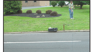
Tira del tubo a través de la carretera.
